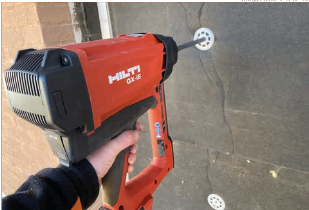
Montaggio isolamento termico
